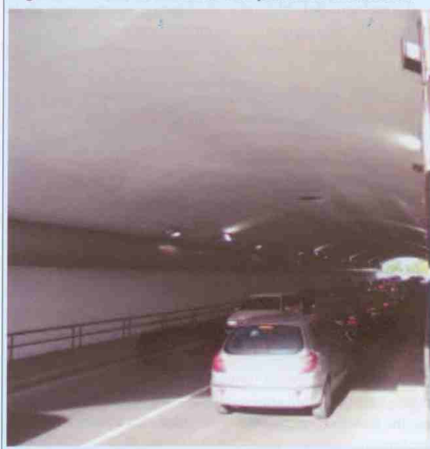
Figura 2 - Galleria rivestita con pittura fotocatalitica
